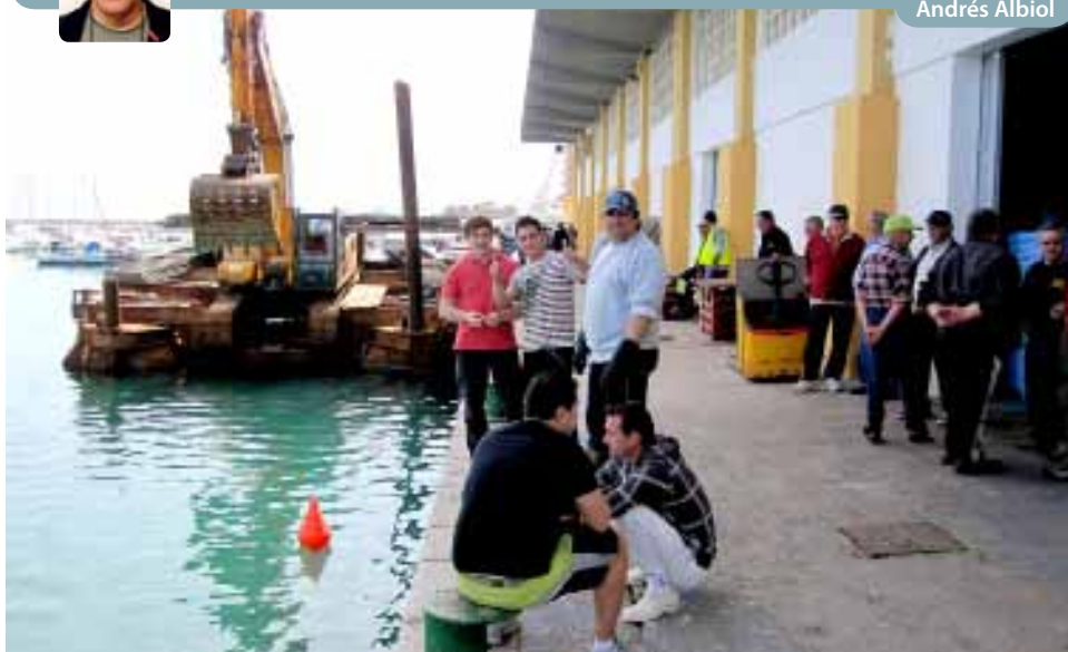
Reparaciones en el muelle de atraque de la Lonja
