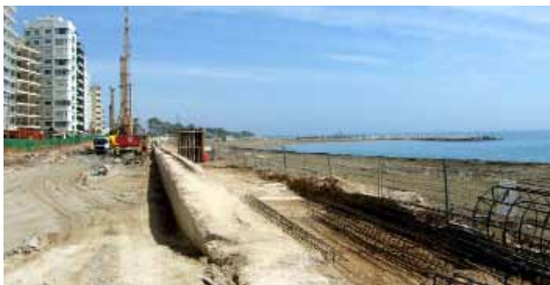
Vista de les obres del passeig i la platja del Fortí
