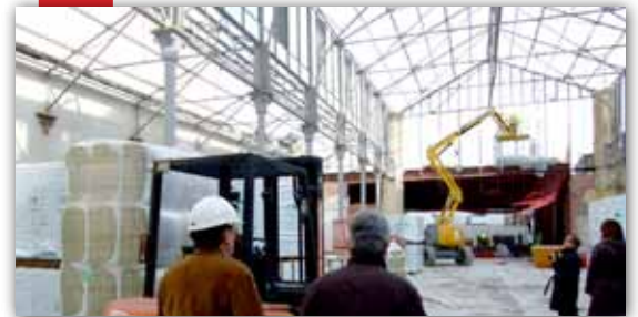
Les obres del mercat, a bon ritme
