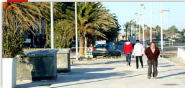
Les obres del passeig marítim, després de Carnaval
