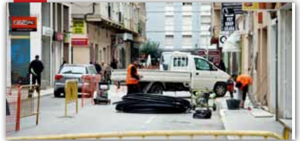
Comencen les obres del carrer Dr Fleming
