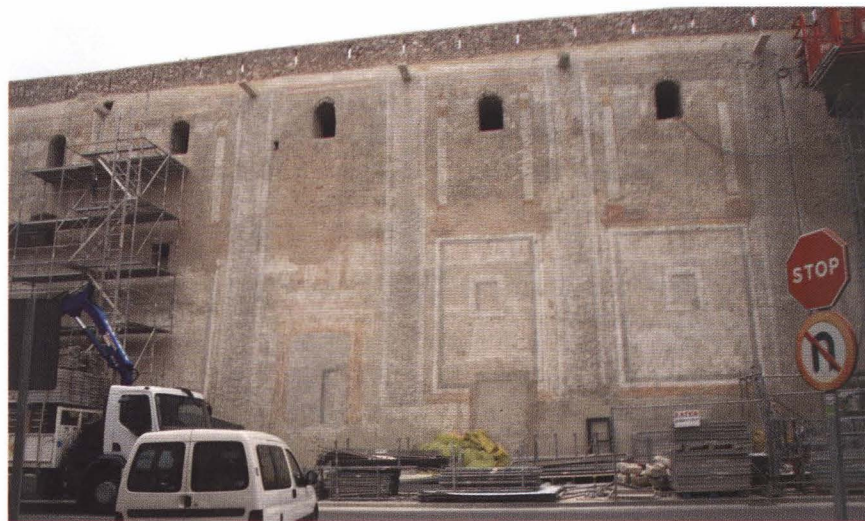
Dimarts es va procedir a retirar les bastides que donen al carrer Sant Cristòfol
