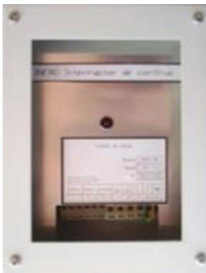
*Ilustración 56: Interruptor de corriente continua.*
