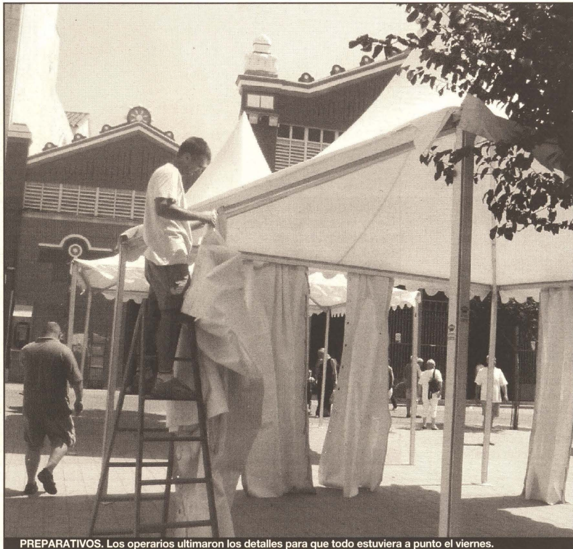
PREPARATIVOS. Los operarios ultimaron los detalles para que todo estuviera a punto el viernes.
