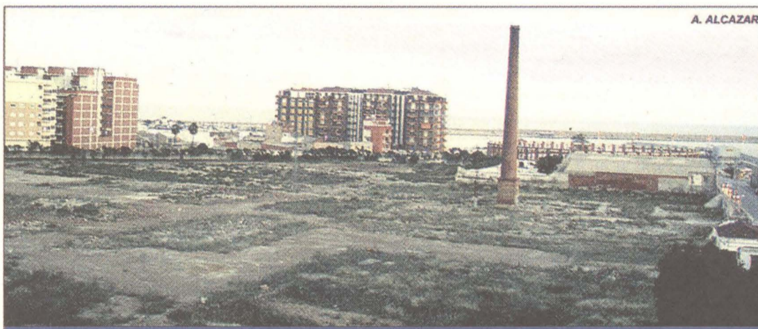
ESTADO ACTUAL. Tras la demolición de la zona fabril, se aprecian las dimensiones del solar
