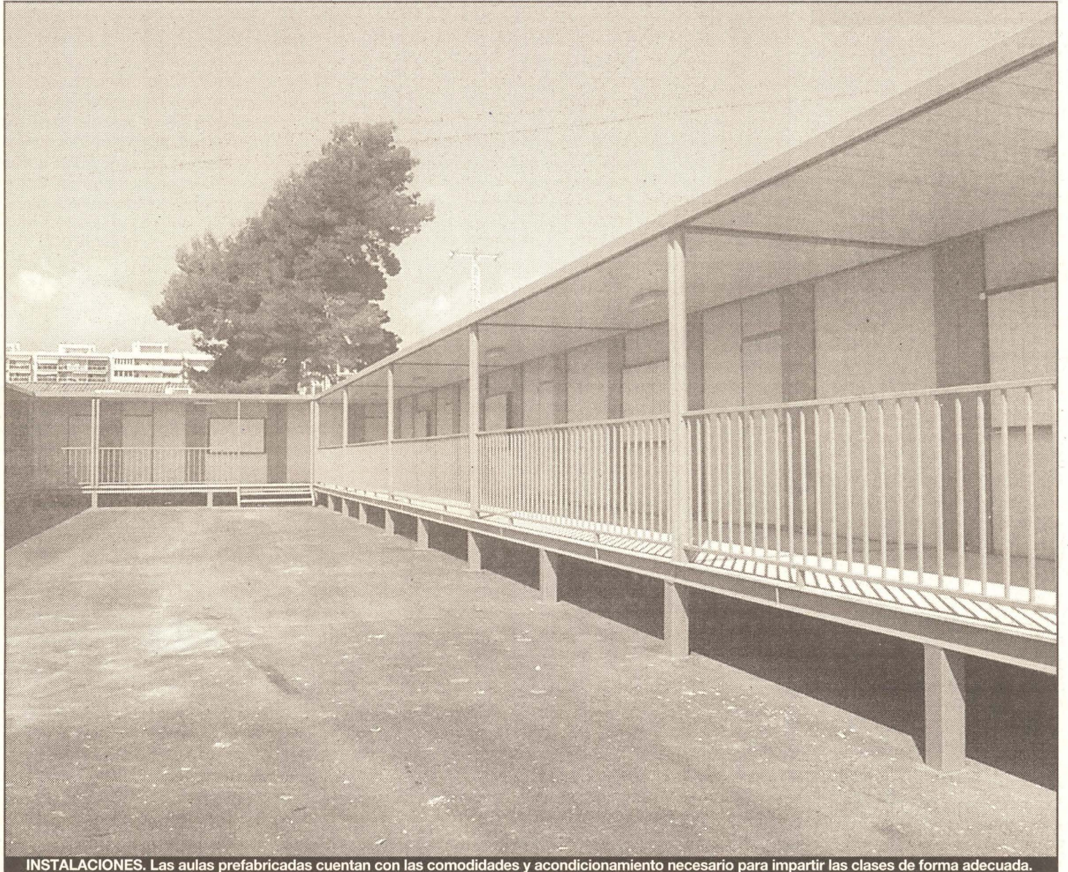
INSTALACIONES. Las aulas prefabricadas cuentan con las comodidades y acondicionamiento necesario para impartir las clases de forma adecuada.
