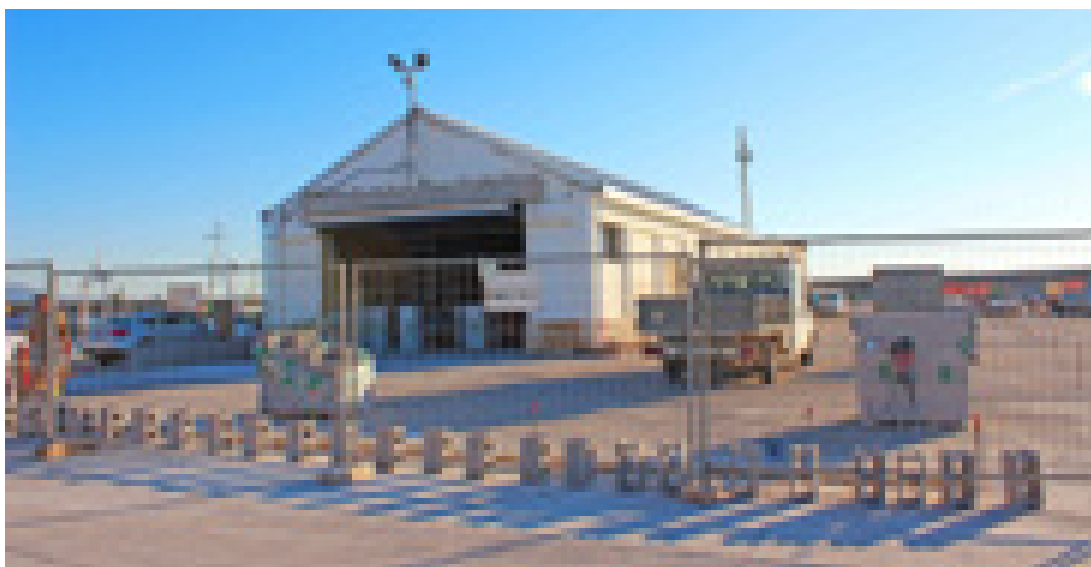
Esta semana se estaban realizando las correspondientes obras en una nave que albergará el nuevo almacén de Castor en el puerto
