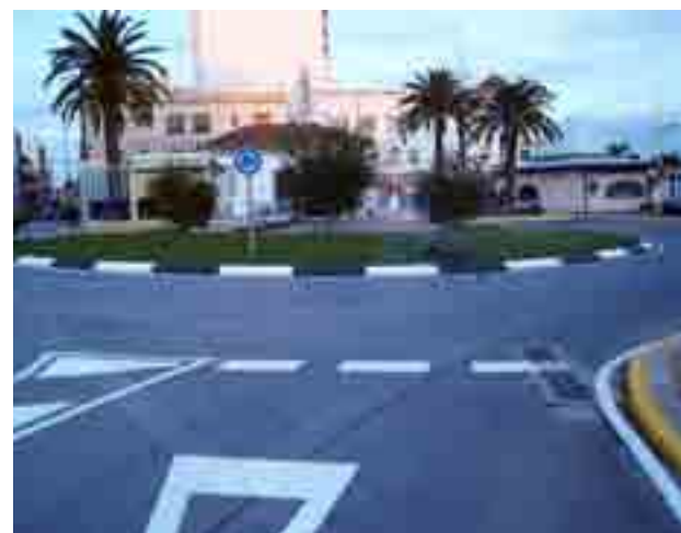
La remodelación ha mejorado el interior de la rotonda
