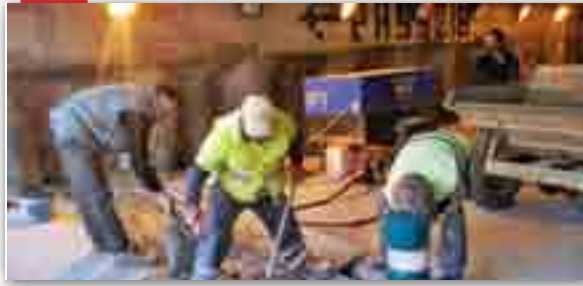
Reparan desperfectos en el pàrking del paseo marítimo
