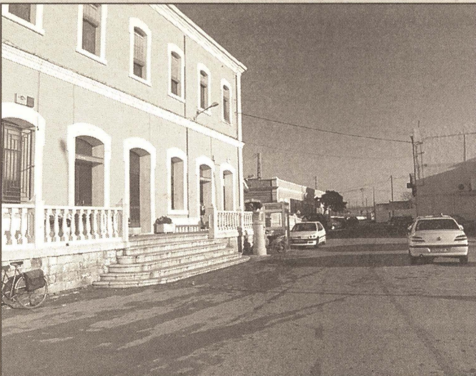
FERROCARRIL. El edificio de la estación de ferrocarril está a punto de cumplir 90 años.
