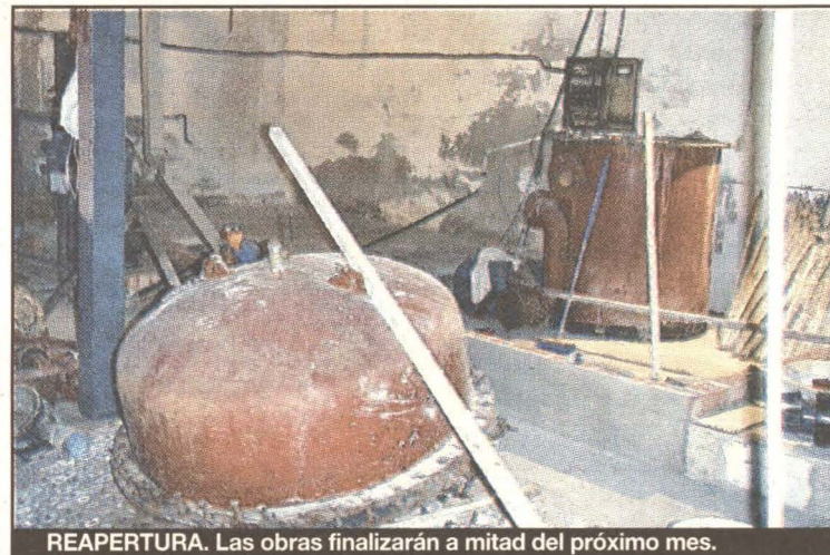
REAPERTURA. Las obras finalizarán a mitad del próximo mes.
