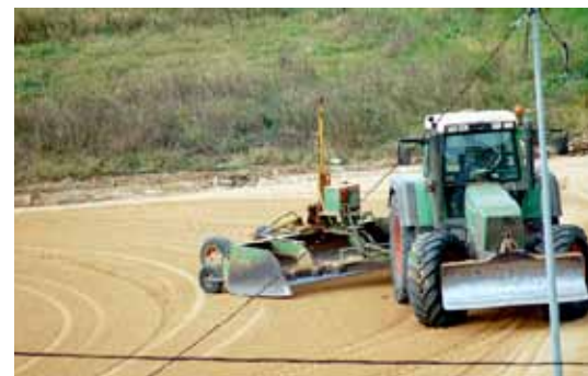
Actualmente, en este entorno, el Ayuntamiento está acondicionando, para la ciudadanía, un aparcamiento provisional en la zona más próxima a los colegios.
