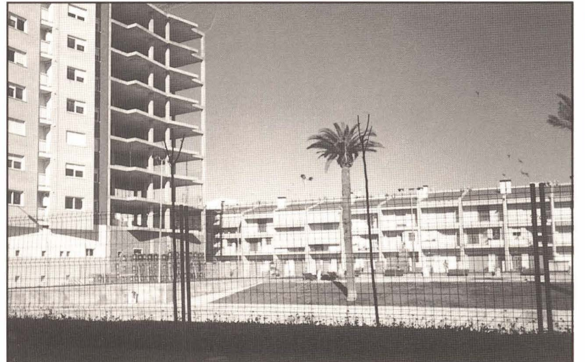
Estado actual de la plaza, unas vallas a su alrededor prohíben el acceso
