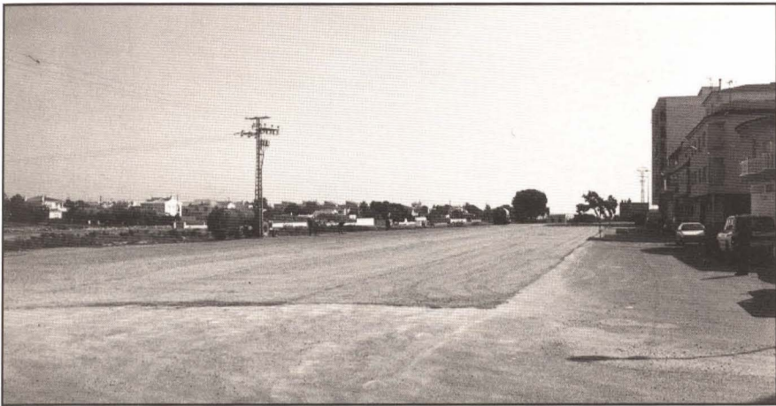
La zona se está acondicionando. Foto: A. Alcázar
