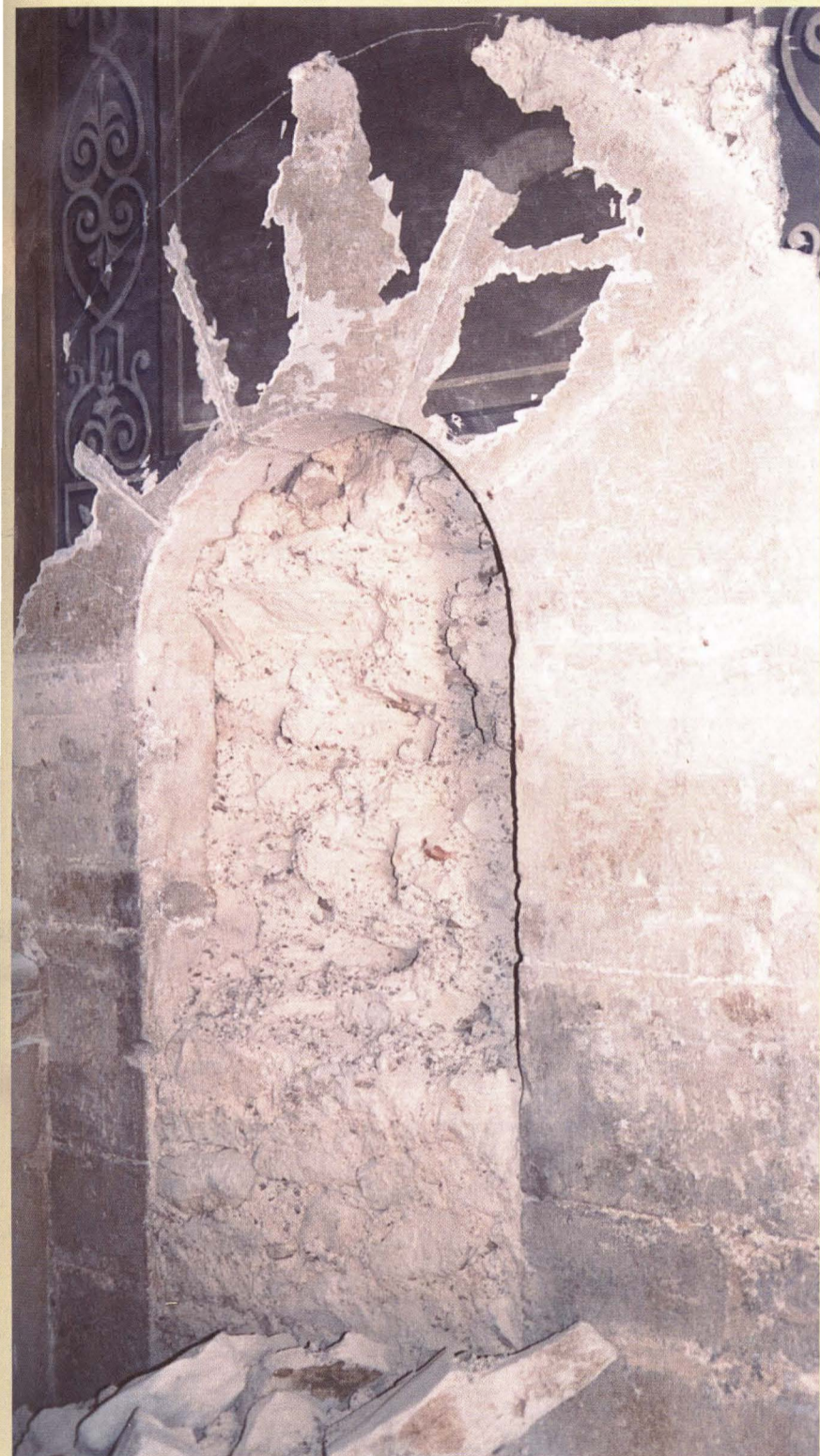
Arc recentment descobert a l'interior de L'Ermita de la Misericòrdia
