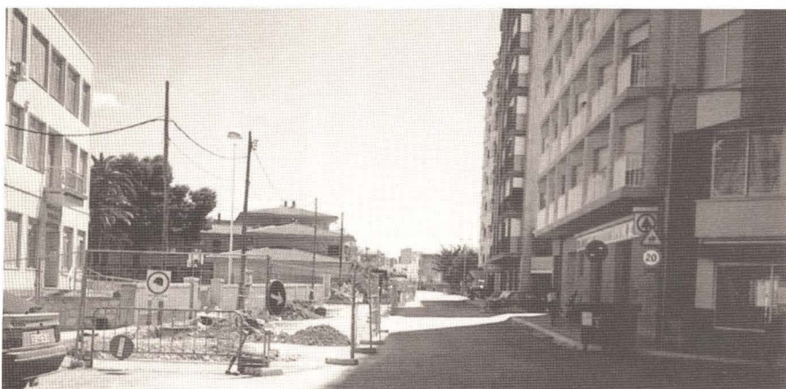
Se urbaniza la Avda. Libertad entre la calle Pilar y Camí Carreró.
