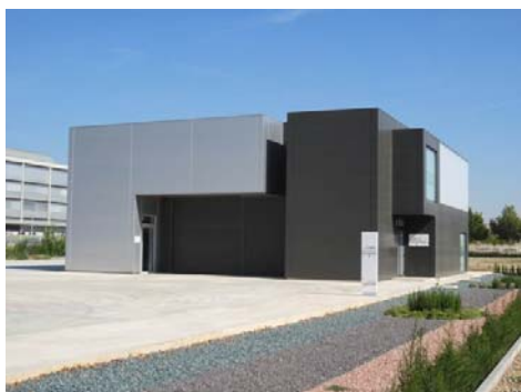
Edificio CD TIC Logística
