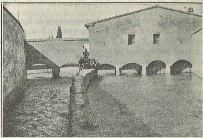
Edificio con las compuertas para las aguas correspondientes a Nules y Burriana
