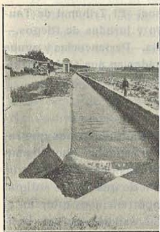
Caja del medidor, acequia de Burriana
