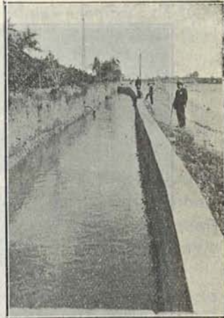
Acequia común, después de hecho el ensanche de cuatro metros
