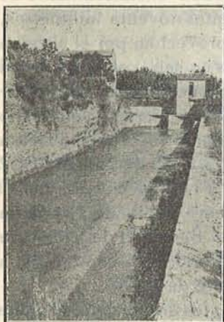
Presa del Azud
