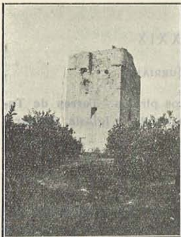
Torre del Mar
