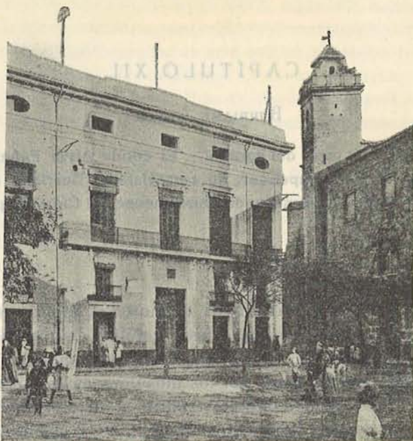
Torre del Caracol y Casa Ayuntamiento.
