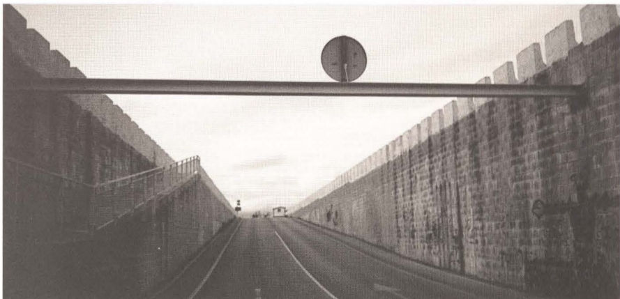
VINARÒS. Paseo subterráneo que une las avenidas de Pío XII y Juan XXIII. El Conseller de Obras Pùblicas en Traiguera manifestó: NO HAY NINGÚN INCONVENIENTE EN SUBVENCIONAR LAS OBRAS A REALIZAR EN AMBAS AVENIDAS AL CIEN POR CIEN.
