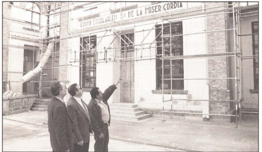
El Director Territorial de Cultura y Educación, Francisco Baila, acompañado por el alcalde de la ciudad, Jacinto Moliner, visitó in situ las obras de remodelación que se efectúan en el C.P. Mare de Déu de la Misericòrdia. Foto: A. Alcázar
