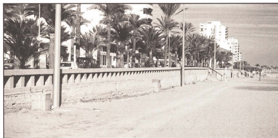
Próximamente se instalarán los puntos de luz en la Platja del Fortí. Foto: Difo's
