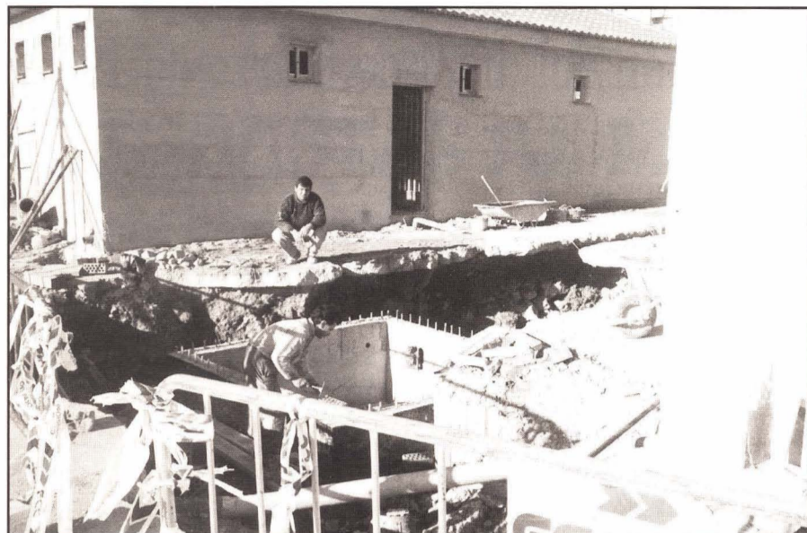
Terminaron los trabajos de remodelación de desagües y servicios en la Lonja. Foto: A. Alcázar
