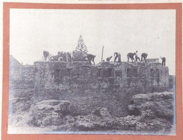
27.-Derribo de un torreón de la muralla
