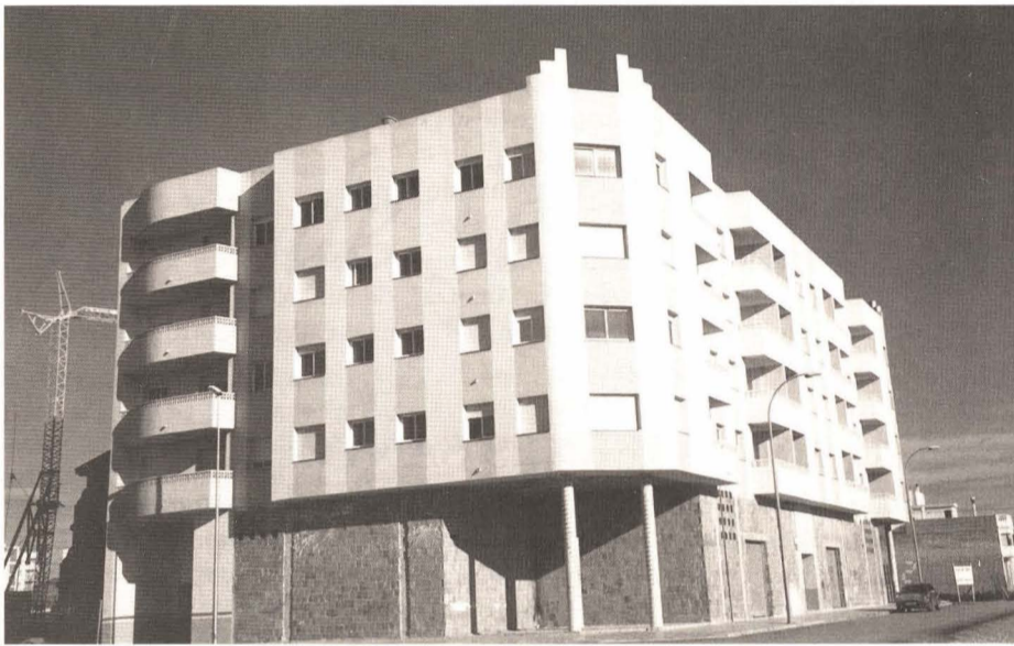
EDIFICIO NEPTUNO. Avda. Picasso, 42 - VINARÒS
