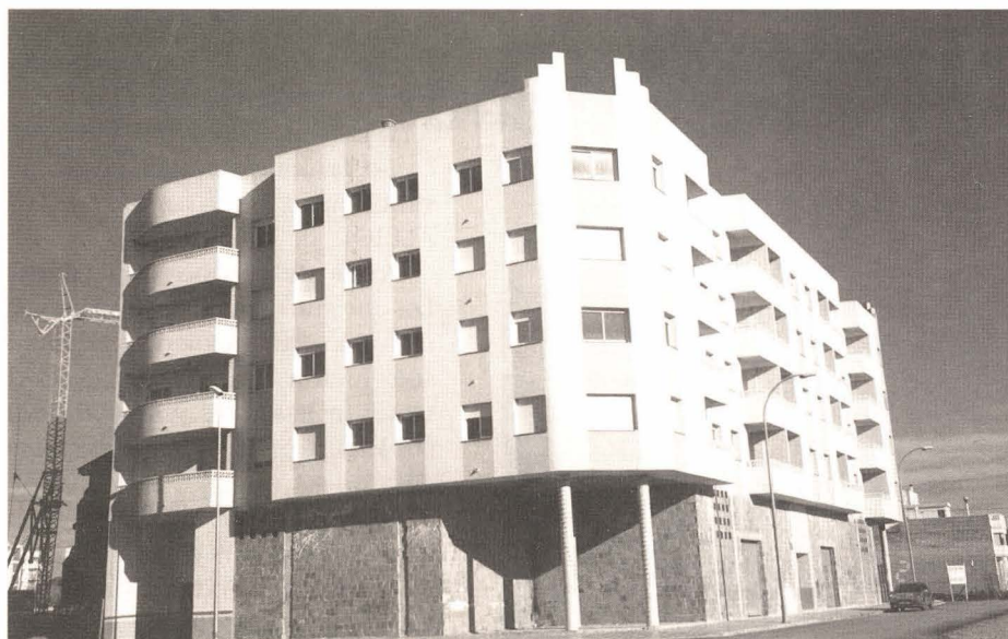
EDIFICIO NEPTUNO. Avda. Picasso, 42 - VINARÒS
