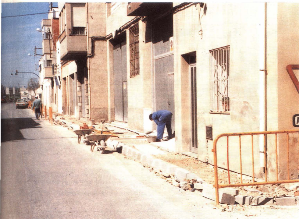
Continúan a buen ritmo las obras de las aceras de la calle del Pilar. Foto: Reula
