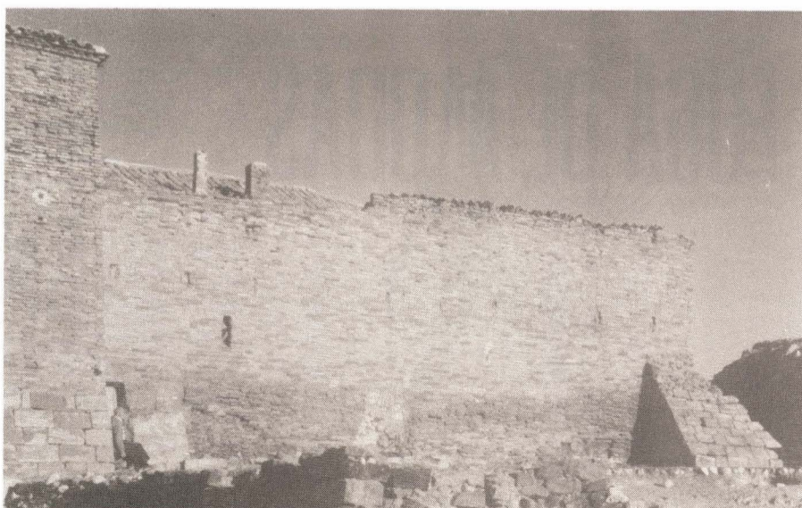
Muro occidental de la fortaleza de los Atrossillo, con el contrafuerte central (ver foto arriba) y el refuerzo de la esquina sud. occidental, ataludado. En primer término restos de la muralla exterior del conjunto, actualmente eras para la trilla
