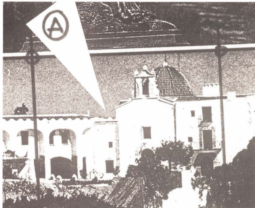
Grabado de la Ermita en que señala la caja de escalera (1700) que debería eliminarse al efecto de reconstruir el destrozado porche y liberar la fachada de ese añadido inaceptable
