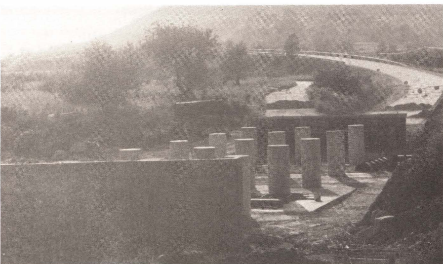
Se está construyendo el puente en la carretera de Càlig-Vinaròs que dejaría en óptimas condiciones las comunicaciones entre las dos ciudades. Foto: Reula
