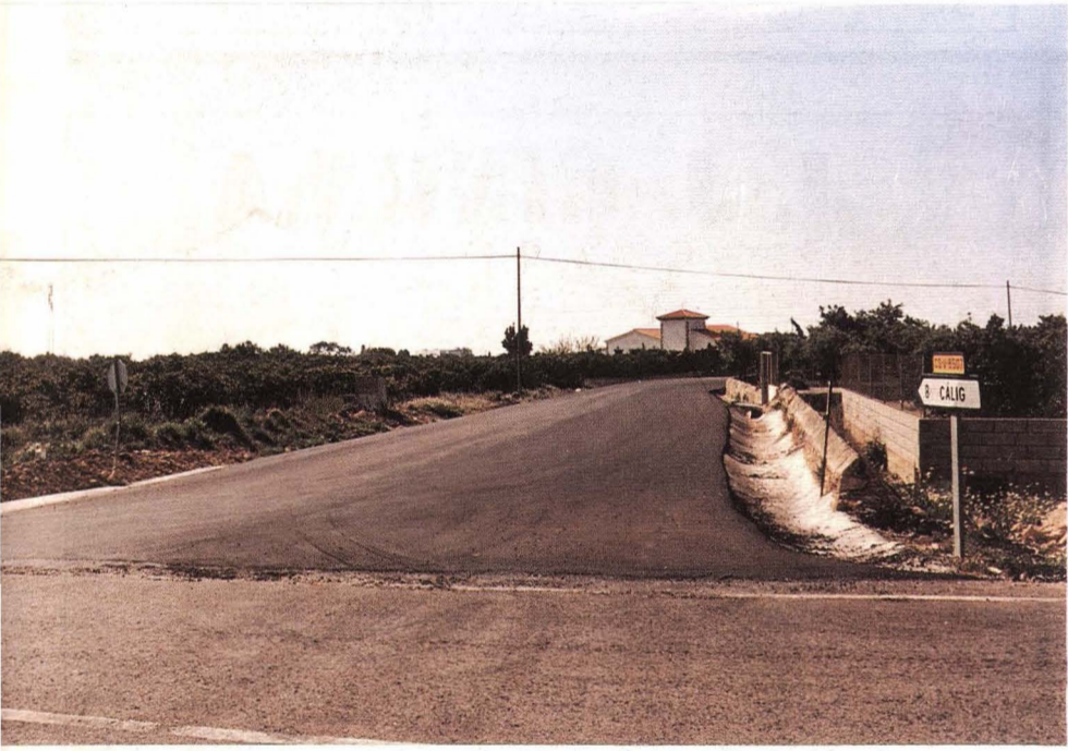
La carretera de Vinaròs a Càlig, en obres. Foto: Reula
