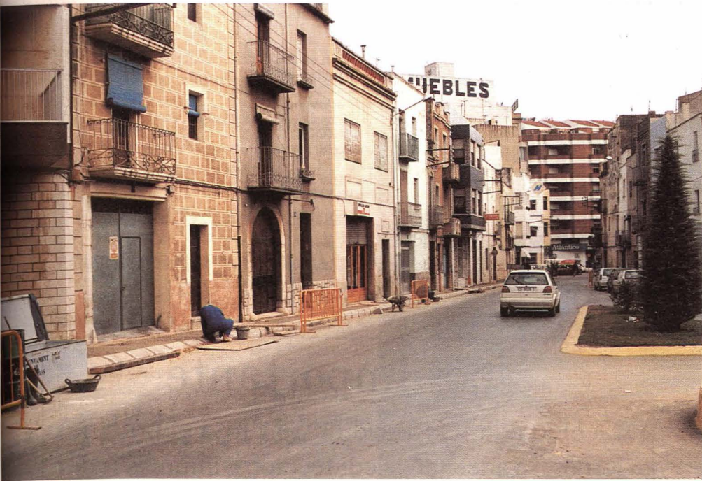
Se están mejorando las aceras de la Calle del Puente.
