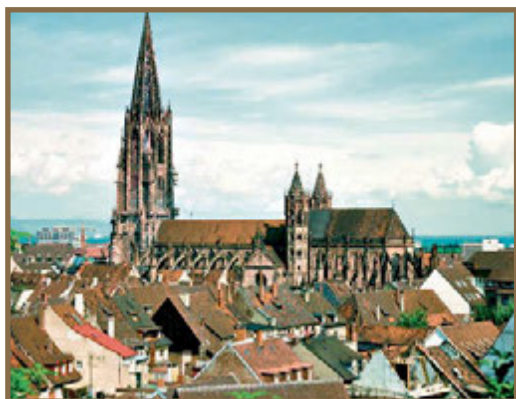
Torre gótica del campanario-catedral de Friburgo.
