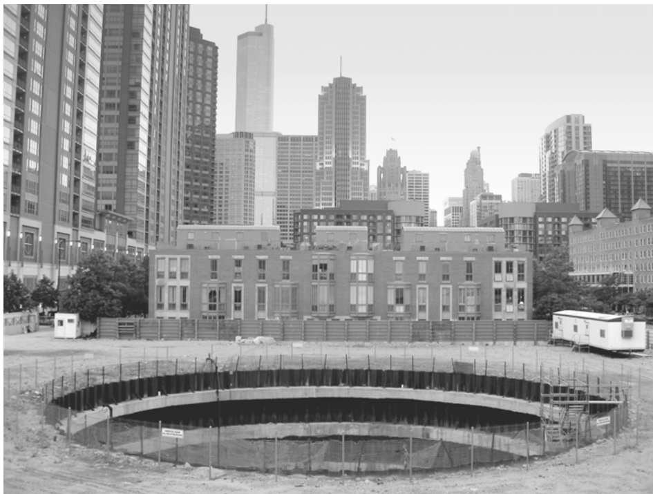
Foto 3. Obres del Chicago Spire abandonades després de la construcció dels fonaments i els murs de contenció dels soterranis al maig de 2010 (Fotografia d'Ivan Cabrera).
