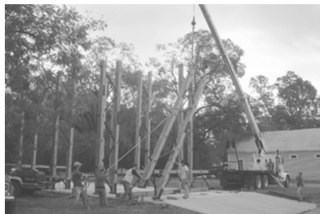
Foto 10. Construcció de la nova estació de bombers de Newbern, Alabama (foto gentilesa de l'Auburn University Rural Studio).
