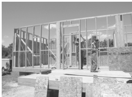
Foto 3. Construcció de la Mac's House, al 2010, a l'estat d'Alabama, dins del programa 20K Houses (foto gentilesa de l'Auburn University Rural Studio).
