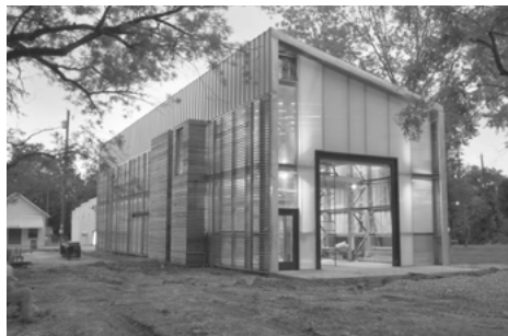
Foto 11. Vista exterior de la nova estació de bombers de Newbern, Alabama.
