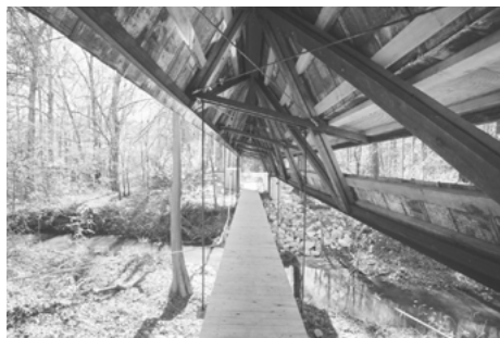
Foto 18. Pont al Perry Lakes Park a Marion, Alabama.
