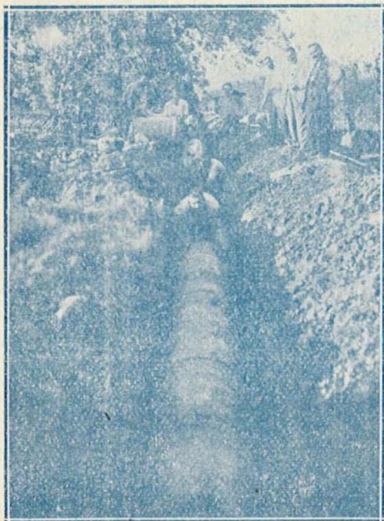
Vista parcial de la instalación de tubería de cemento armado de 2800 metros de longitud, con presión de cinco atmósferas y caudal de 3000 litros por minuto, construída por esta CASA para la Sociedad Pozo "El Diluvio" en Bena-dresa (Castellón)
