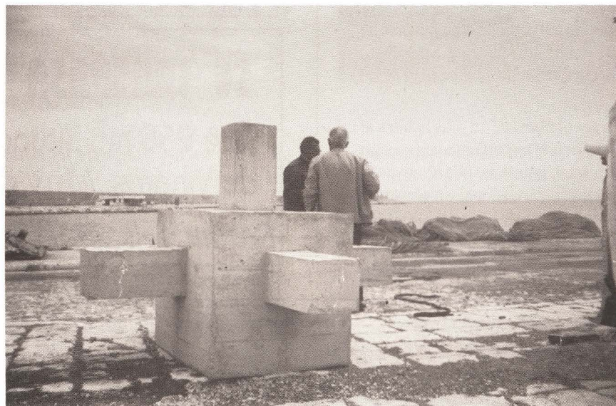
Arrecife artificial preparado para depositarlo al fondo. Foto: A. Alcázar
