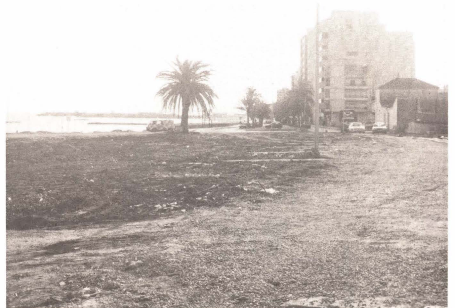
Se vislumbra ya lo que será la prolongación del Paseo Marítimo. Foto: Reula
