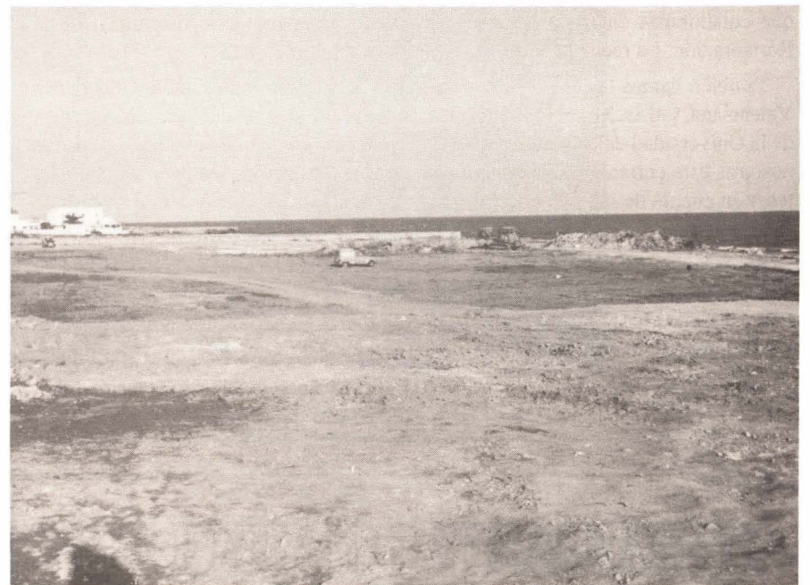
Se han derribado los edificios afectados por la expropiación. Foto: Reula
