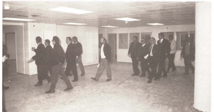
El Hospital Comarcal, una joya de Vinaròs. La obra prácticamente terminada. Foto: A. Alcázar
