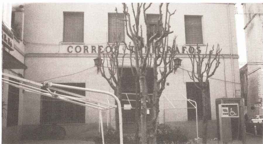
L'edifici està ara en obres. Foto: A. Alcázar
