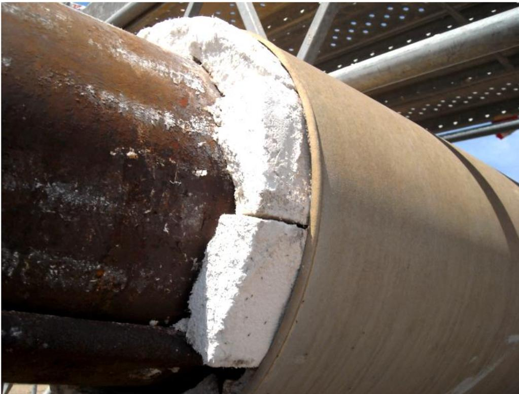
*Imagen 17: Chapa de calorifugado aplicada a una tubería.*
