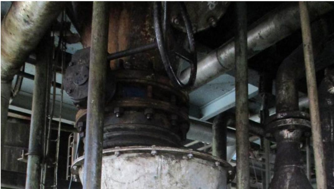
*Imagen 11: Conjunto válvula-reductora instalados en el depósito.*
