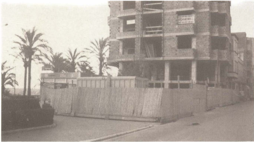
Las ocupaciones, por obras, de la vía pública, resulta ya una auténtica invasión
