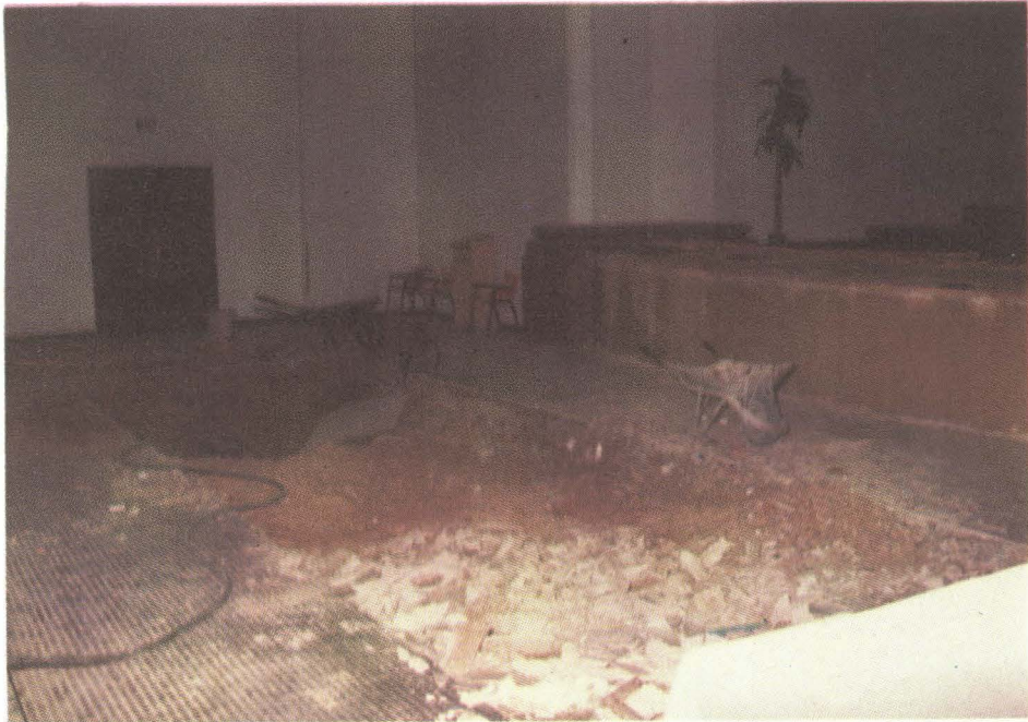
Han començado las obras de aire acondicionado y calefacción en el Auditori Municipal. Fotos: Reula
