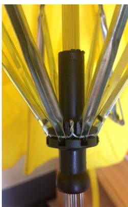
*Imagen 5.1.1 - Unión de las varillas al soporte.*
