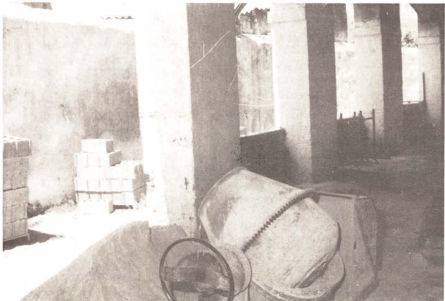
La Plaza de Toros se está remozando para las próximas Fiestas. Se está construyendo una manga para el embarque y desencajamiento. Foto: Reula
