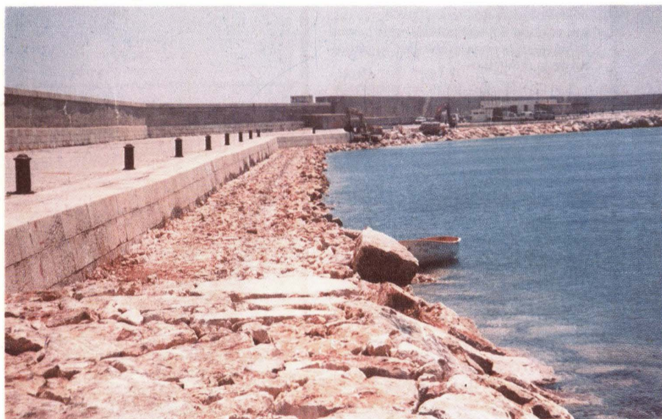
Obras de acondicionamiento del puerto. Foto: Reula
