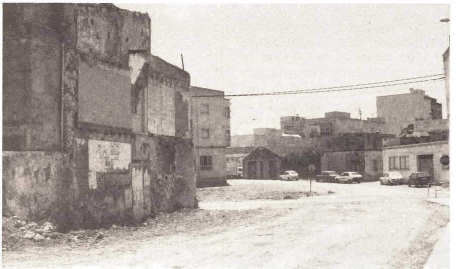
Las obras de acondicionamiento y mejora de nuestras calles. Magnífica ha quedado la explanada en el cruce de la antigua báscula municipal. Foto: Reula
