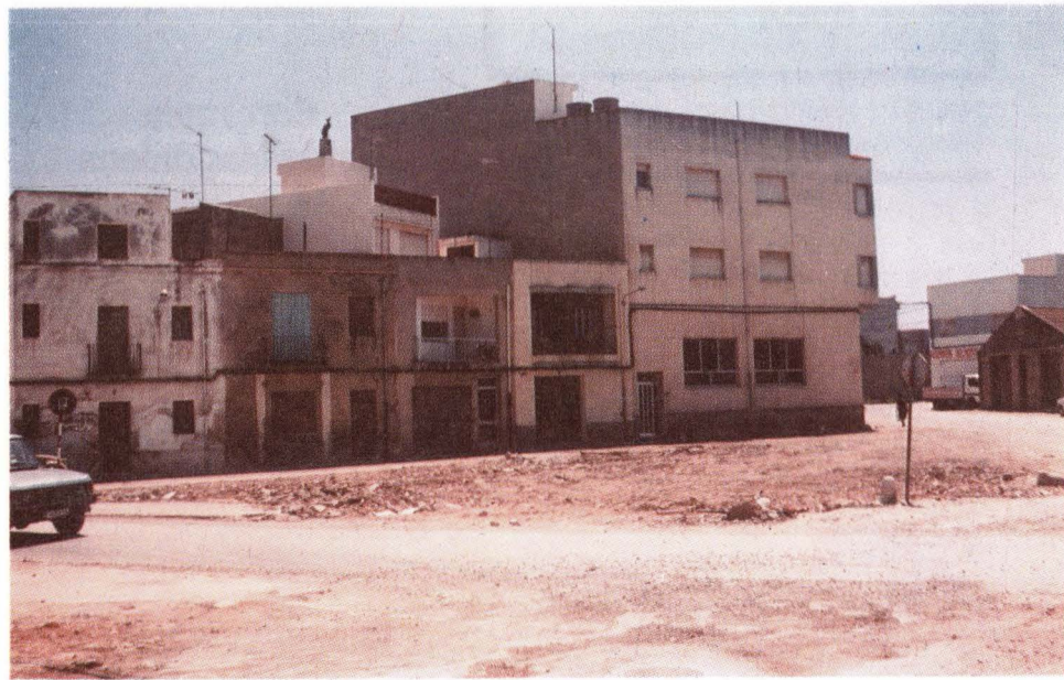
Derribo de la manzana en la antigua «báscula». Foto: Reula
