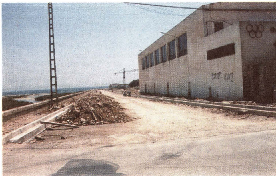
Obras de apertura de la nueva calle, junto al Pabellón que enlazarán la Avda. Tarragona con la prolongación del Paseo.
