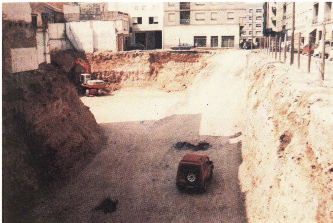
Espectaculares obras en el cruce Socorro-Dtor. Fleming. Foto: A. Alcázar
