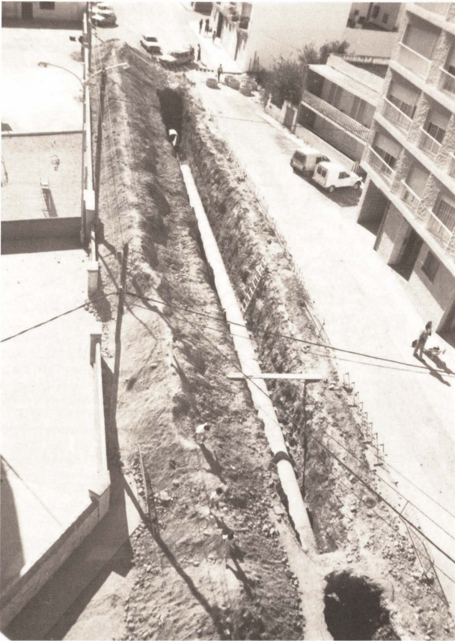
Segueixen les obres del col·lector general. Foto: A. Alcázar
