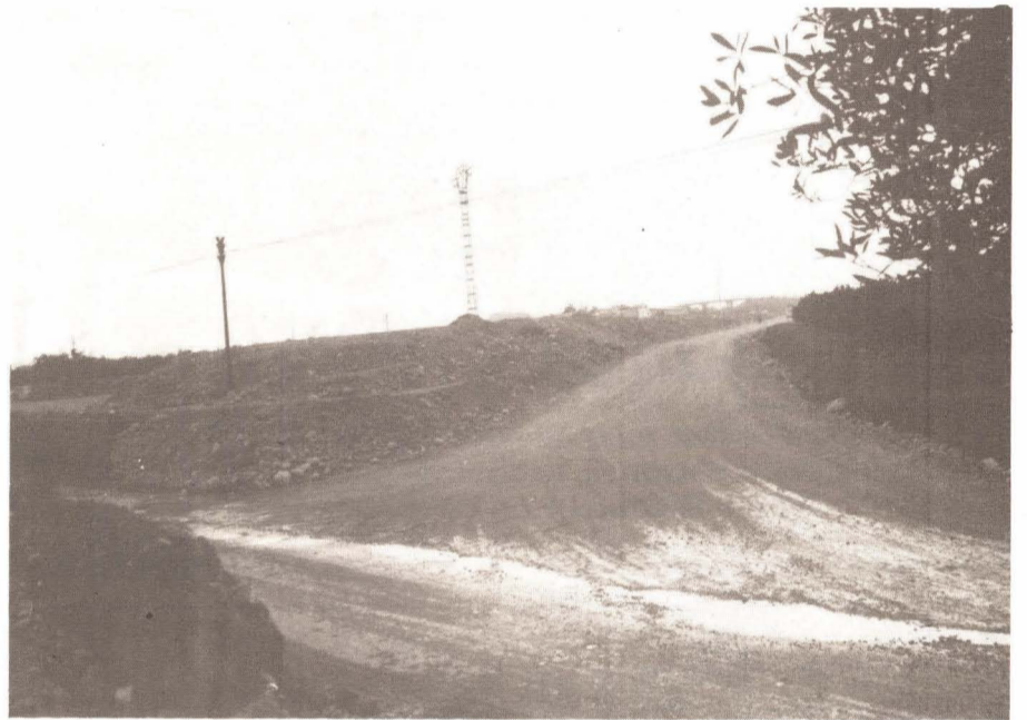
Obras para la instalación de la doble-vía. Foto: Reula
