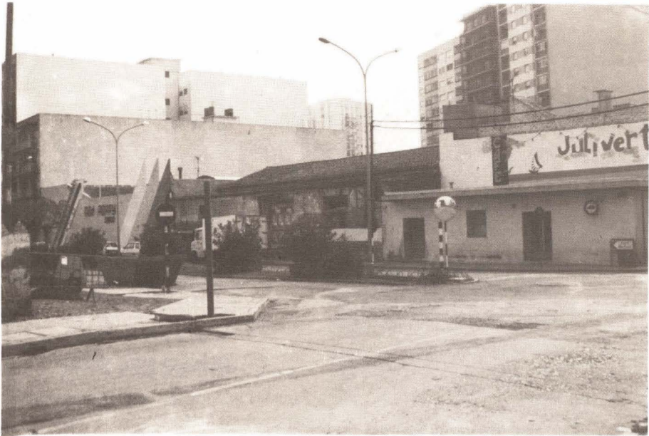
Han empezado las obras de instalación de semáforos. Foto: Reula
