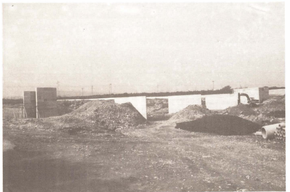
Obras del puente sobre el río Cervol para la construcción de la doble-vía. Foto: Reula
