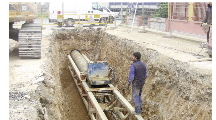
Obres al carrer Santa Magdalena
