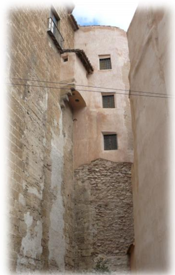
(41.Vista de la Torre desde la calle
