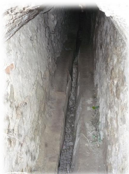
(8.Canalización bajo la muralla)
