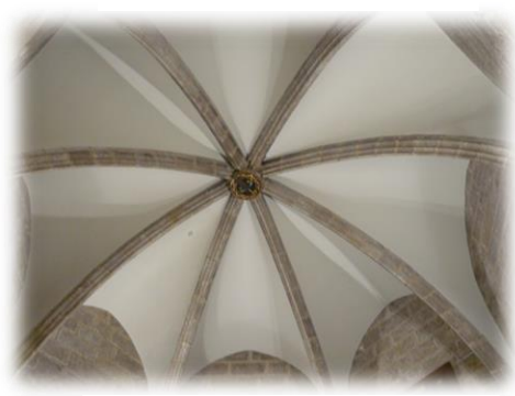
(65.Techo del Aula Capitular)
