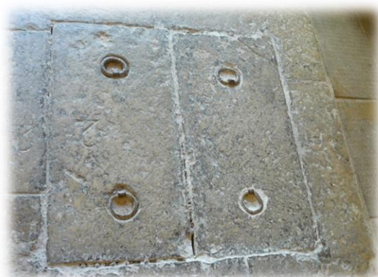
(54.Trampilla de acceso a las Criptas)
