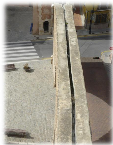
(7.Vista del canal del Acueducto)
