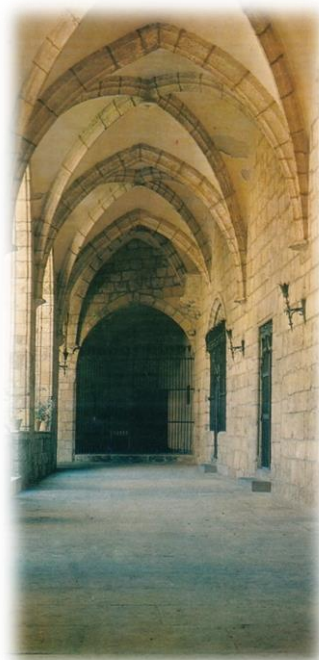
(53.Nave del Claustro)
