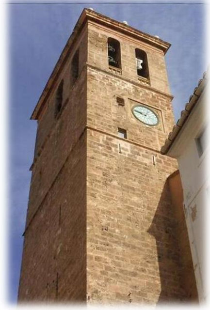
(37. Campanario. Fachada de la calle Colón)
