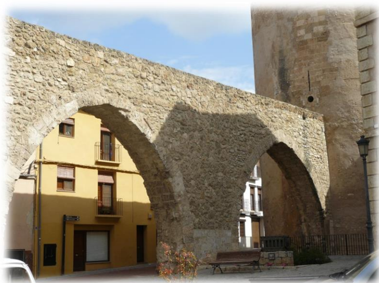
(6.Vista lateral del Acueducto)
