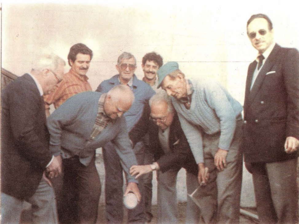
Colocación de la 1ª piedra de la Capilla de la Plaza de Toros
